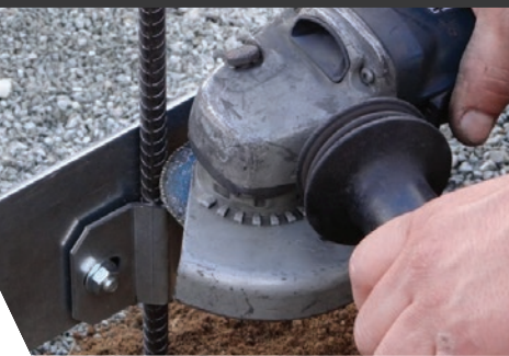
Einfache Längen-Anpassung eines zu langen Ankerstabes nach Montage
